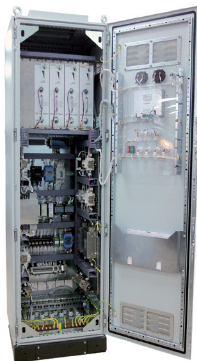
ШНЭ8003-1-40-220-ХХ-1 УХЛ4 с зарядно-питающими устройствами ЗПУ-10Е (вид с открытой дверью)
