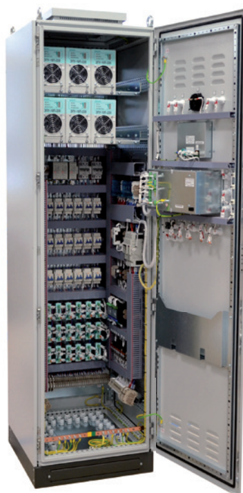
ШНЭ8003-2-37,5-220-60-1 УХЛ4 с зарядно-питающими устройствами ЗПУ-10 и системой контроля изоляции ЭКРА-СКИ
